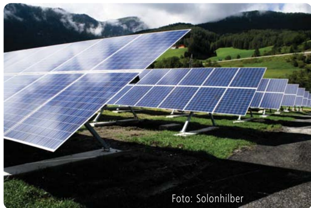
Bild 5: Bei den Solarstromkraftwerken der Solon Hilber Technologie GmbH werden die Solarmodule dem Sonnenstand nachgeführt und erreichen dadurch, je nach Nachführungstechnologie, einen Energiemehrtrag von 22 bis 38% gegenüber fix installierten Anlagen.
